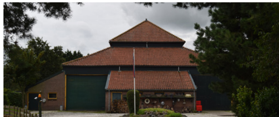
Voorbeeld van het Haarlemmermeerse boerderijtype. Hier is het opgetilde dak, dat oorspronkelijk bedoeld was om meer ruimte en licht te creëren, goed te zien. (Kathrin Vierveijzer)
