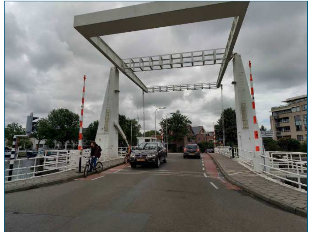
Figuur 24: Aanzicht van de Lisserbrug vanaf de Lisserbroekerweg
