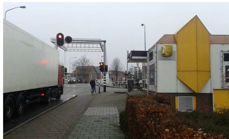
Figuur 25: Aanzicht van de Lisserbrug vanaf de Lisserbroekerweg (2)
