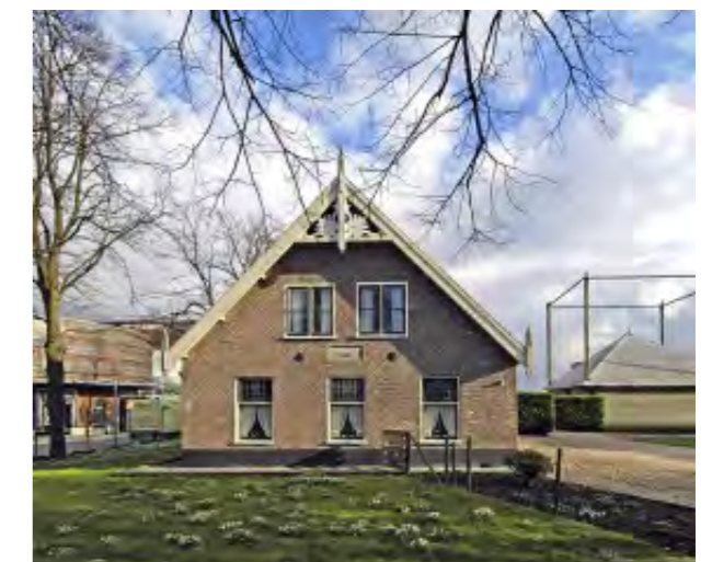
Hendrikskamp aan de Hoofdweg in Graan voor Visch Zuid als voorbeeld voor te behouden bebouwing en als verbijzondering (1861)
