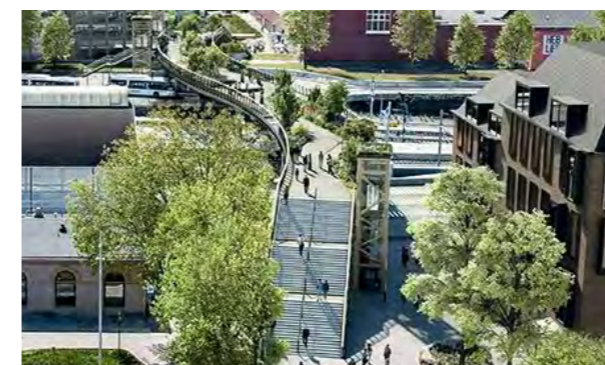
Passerelle Zwolle, als groene verbinding over het spoor, Karres en Brands
