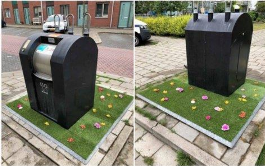
Figuur 14: voorbeeld van ondergrondse containers
