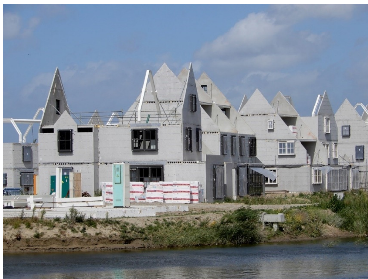
Afbeelding 2: Werkzaamheden bij het Tudorpark
