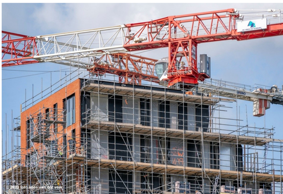
Afbeelding 3: Bouwwerkzaamheden bij Hyde Park
