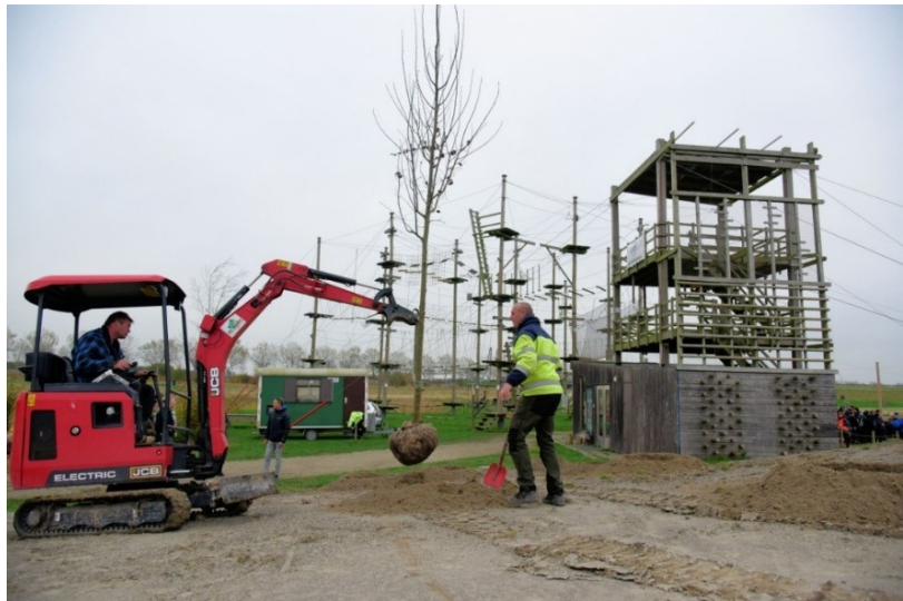
Afbeelding 1: Werkzaamheden aan Klimpark21 in PARK21
