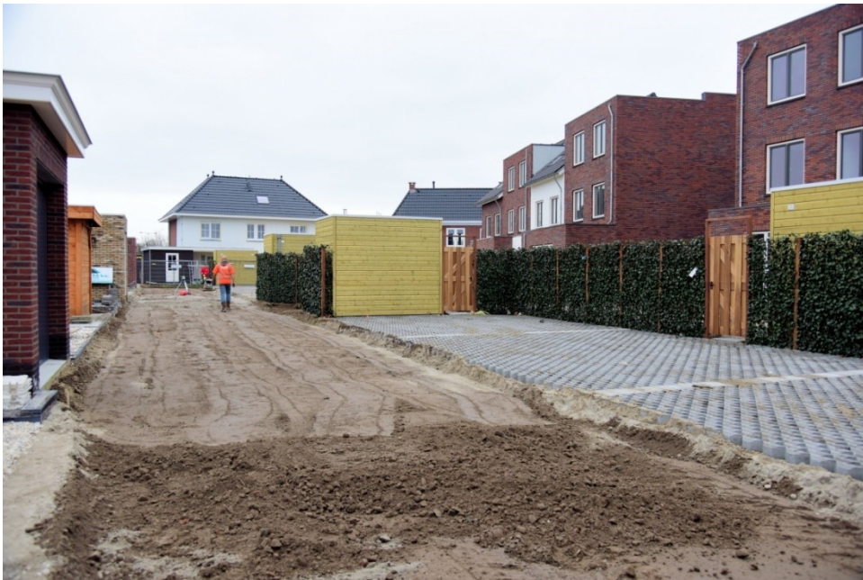
Afbeelding 4: Werkzaamheden aan het Nassaupark
