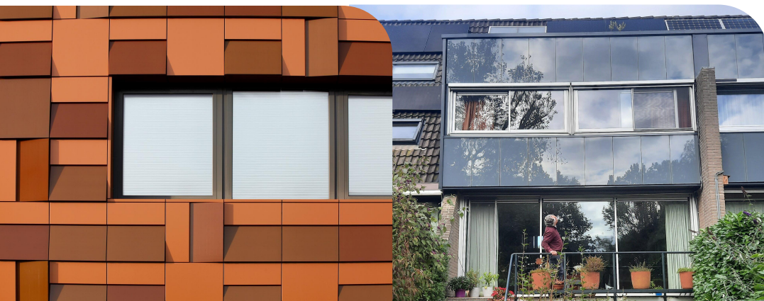
Zonnepanelen op gevels, Ideeënboek SADC
