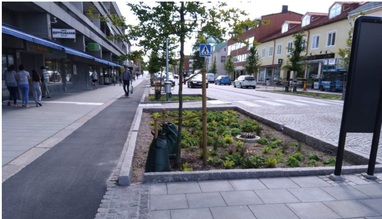
referentie infiltrerende plantvakken met overstort
