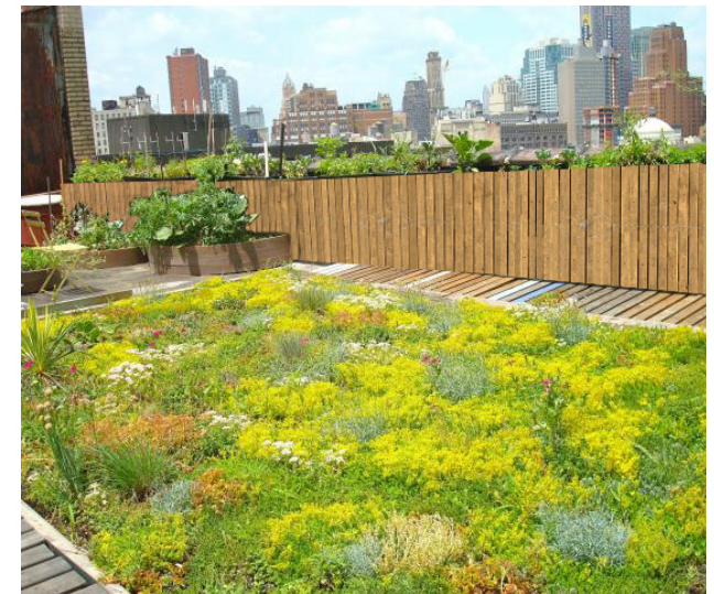
Groen dak heeft een rand en balustrade in materiaal met zo veel mogelijk een zelfde uitstraling
