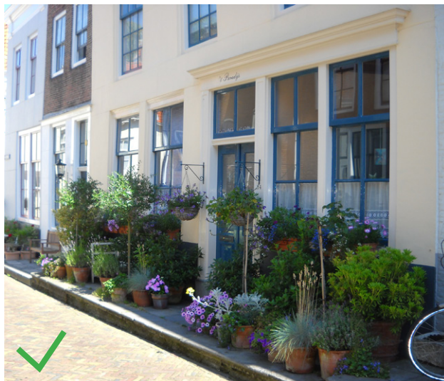
Potten in zone langs de gevel
