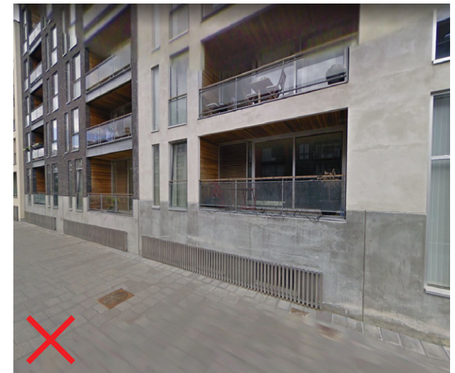
Woning is dusdanig hoog dat contact met de straat minimaal is en eigen entree niet mogelijk
