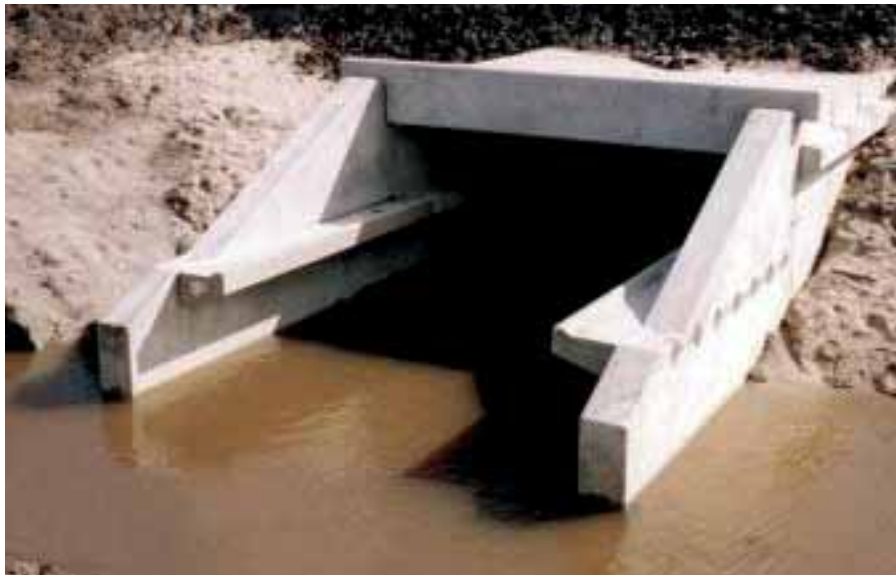
Betonduiker met ecorichel (in uitvoering)
