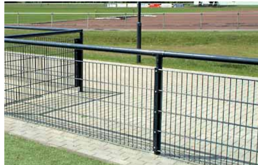
Zijveldhek honk -/softbal 1.2m zwart, transparant hekwerk plaatselijk met poort of deur
