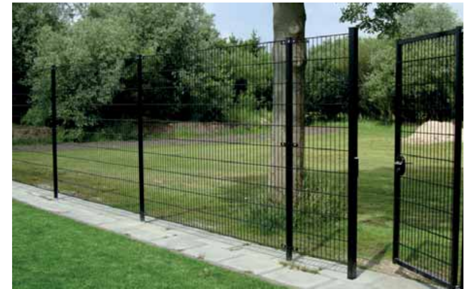
Buitenveldhek honk /-softbal 2m+ zwart, transparant hekwerk plaatselijk met poort of deur Definitieve hoogte nader te bepalen
