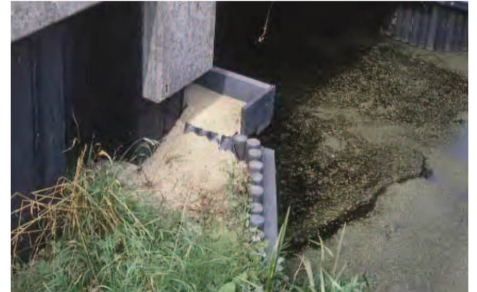
Faunarichel toevoegen aan bestaande betonduiker
