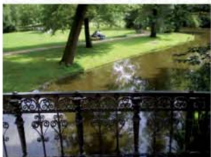
Markante brug en flauw talud
