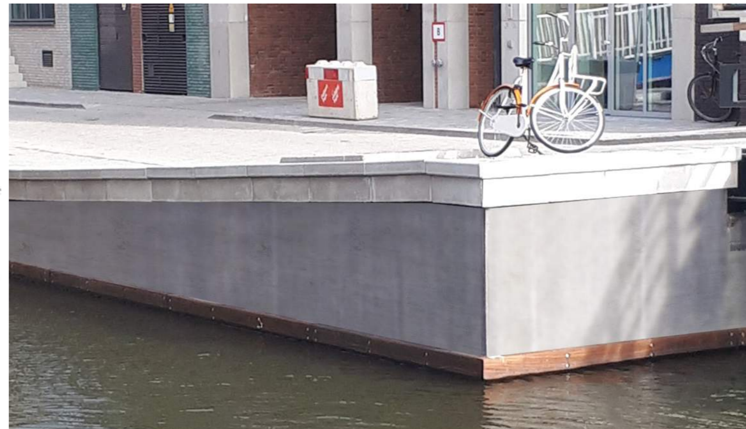
kademuur beton met deksloof
