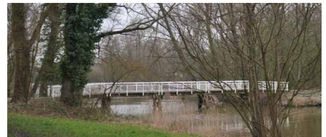
Bestaande brug hergebruiken
