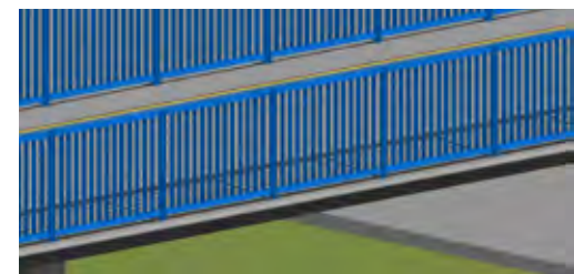
Basisleuning uit kokerprofielen en lamellen
