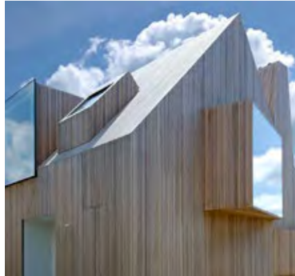
Integrale materialisering van gevel en dak
