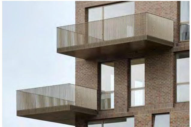
balkon en gevel zelfde materialisering
