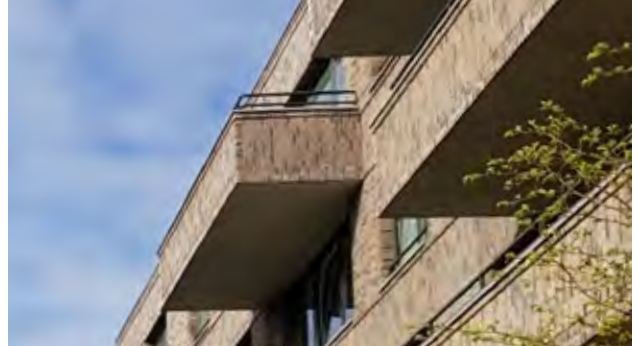
balkon en gevel zelfde materialisering
