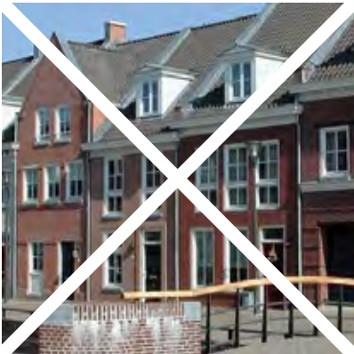
Overstekende dakranden, uitwendige goten en hwa's
