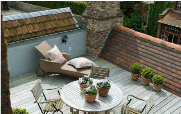
Waterbuffering onder terrasvloer
