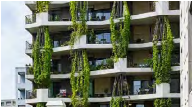
balkons onderdeel van gevel
