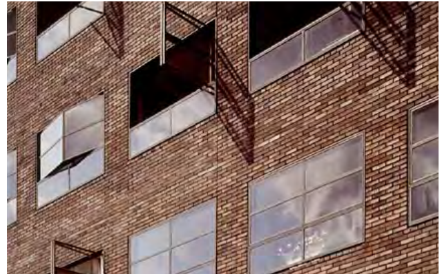
Levendig metselwerk, geraffineerde details
