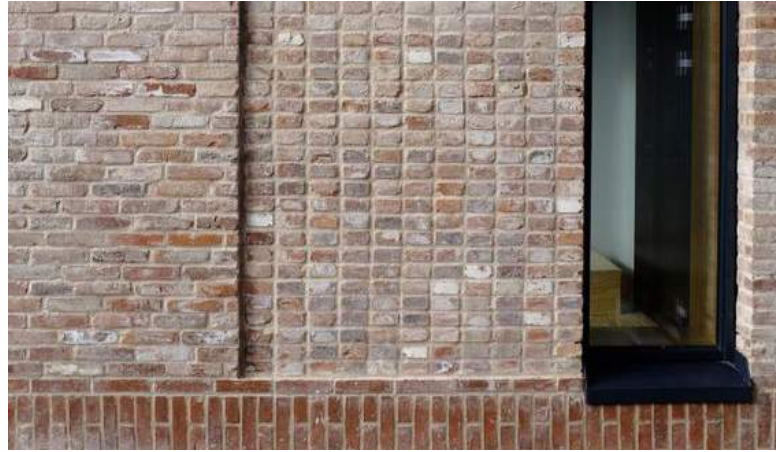
Afbeelding 4.60 - opbreken gevelvlakken middels patronen en vlakken
