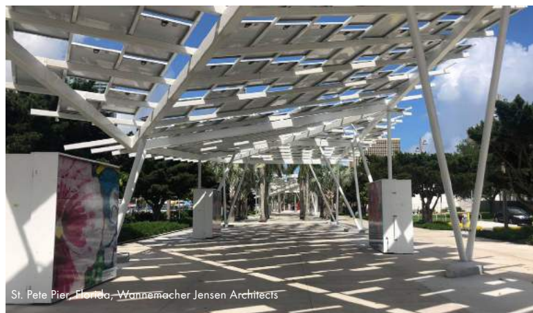
Afbeelding 3.61 Voorbeeld beschaduwing looproute met zonnedak
