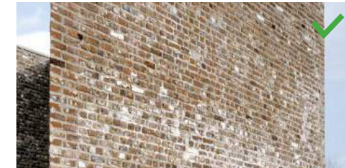
Afbeelding 4.71 - voorbeeld levendig gevelbeeld in baksteen
