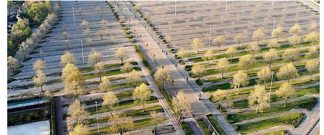
Afbeelding 3.59 Parkeerplaats is deels onverhard (in gras) uitgevoerd
