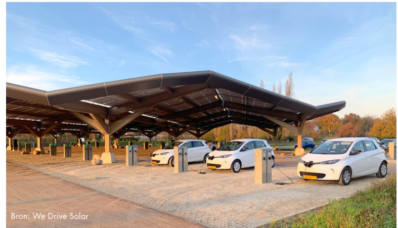
Afbeelding 3.64 Voorbeeld laadplein met zonnepanelen Triodos Bank
