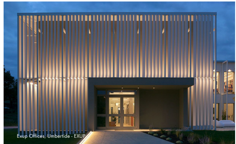
Afbeelding 4.51 - gloeiende verlichting achter de gevel
