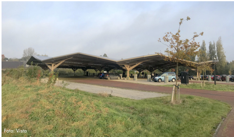
Afbeelding 3.63 Voorbeeld laadplein met zonnepanelen Triodos Bank
