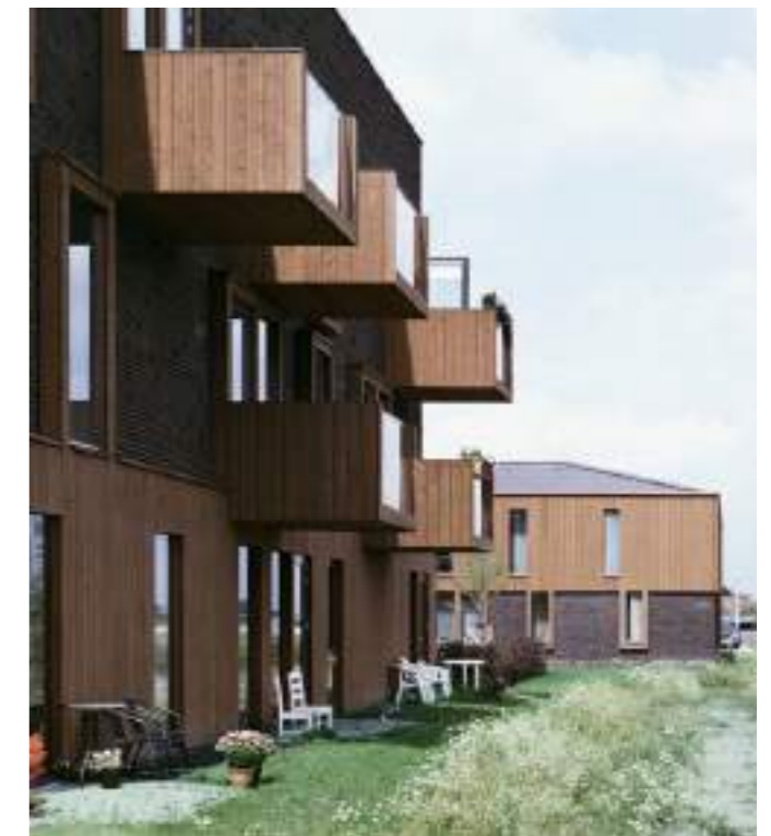
Balkonen aan buitenkant Sprenkelaarshof, Apeldoorn
