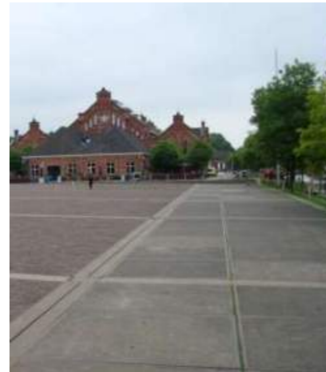
Combinatie betonplaten en klinkers Westerpark, Amsterdam
