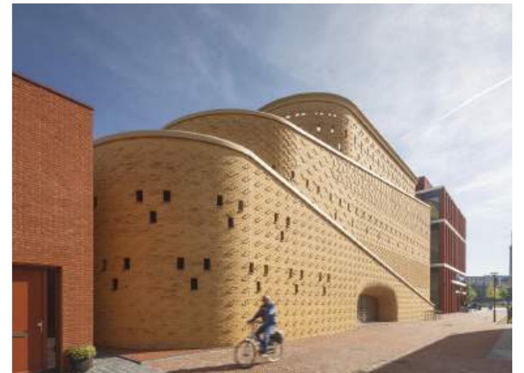
Organisch en diervriendelijk metselwerk (Centrum) Parkeergarage Katwolderplein, DOK architecten, Zwolle
