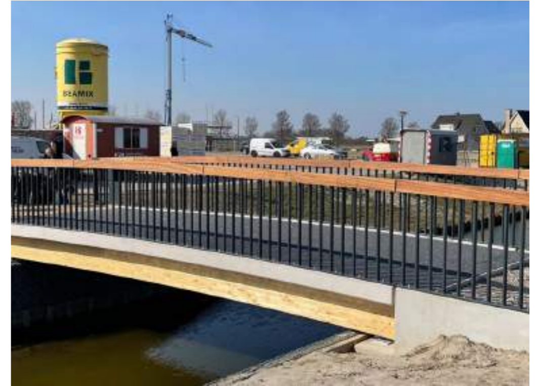
■ Innovatieve hout-betonbrug voor autoverkeer die de voordelen van hout (duurzaam) met die van beton (onderhoudsarm, lange levensduur) combineert. IPV Delft, bruggen Reimerswaal
