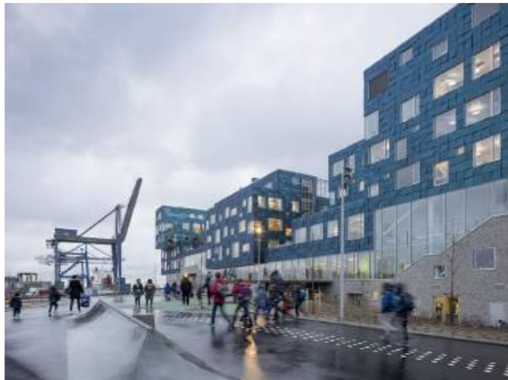
Zonnepanelen als gevel
