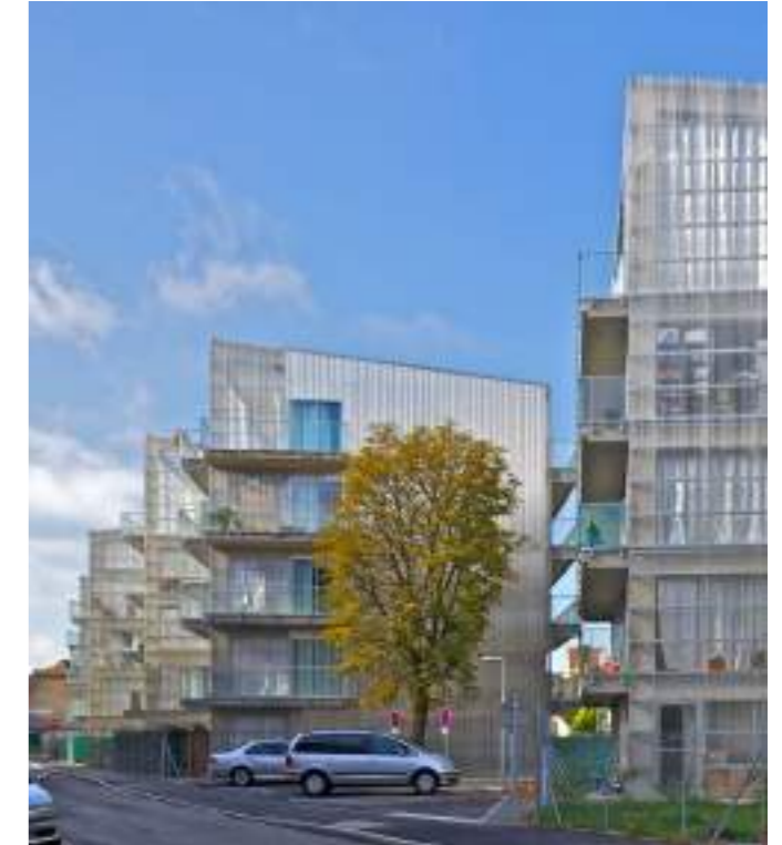
Schuin dak, staal gevel Mulhouse, Frankrijk
