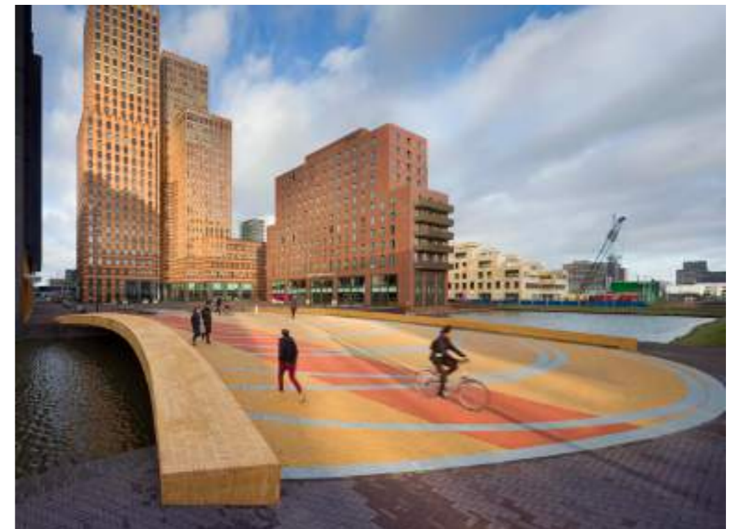
■ Centrale bruggen als plein op het water. Lex van Deldenbridge, Amsterdam
