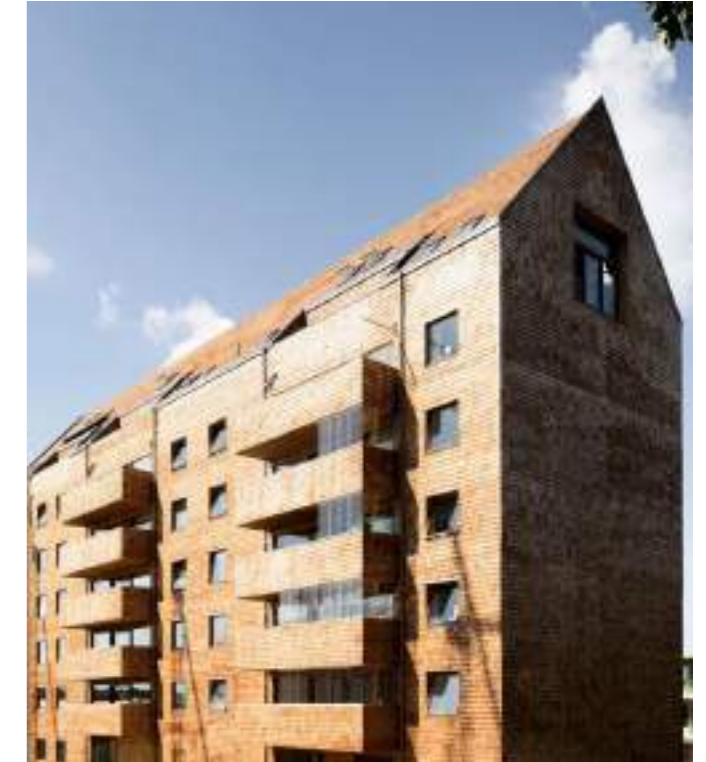
Balkons geven het mede vorm Strandparken Building B, Zweden
