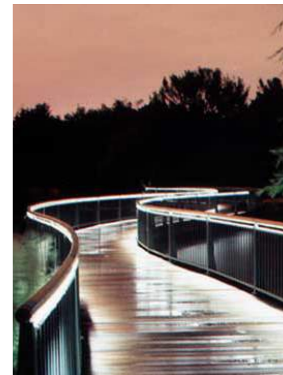
LED-accent verlichting geïnstalleerd in de leuningen
